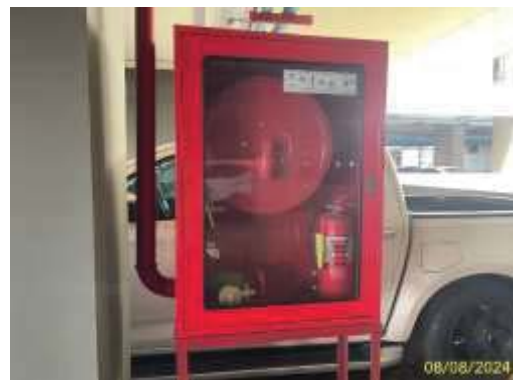
ตู้เก็บสายฉีดน้ำดับเพลิง พร้อมถังดับเพลิงชนิดมือถือ
